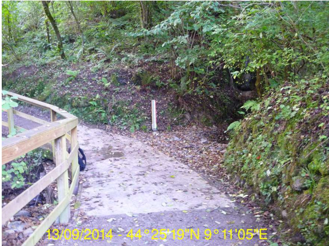
Figura 10: Guado in comune di Tribogna. Si noti la colonnina per l'indicazione del livello dell'acqua.
