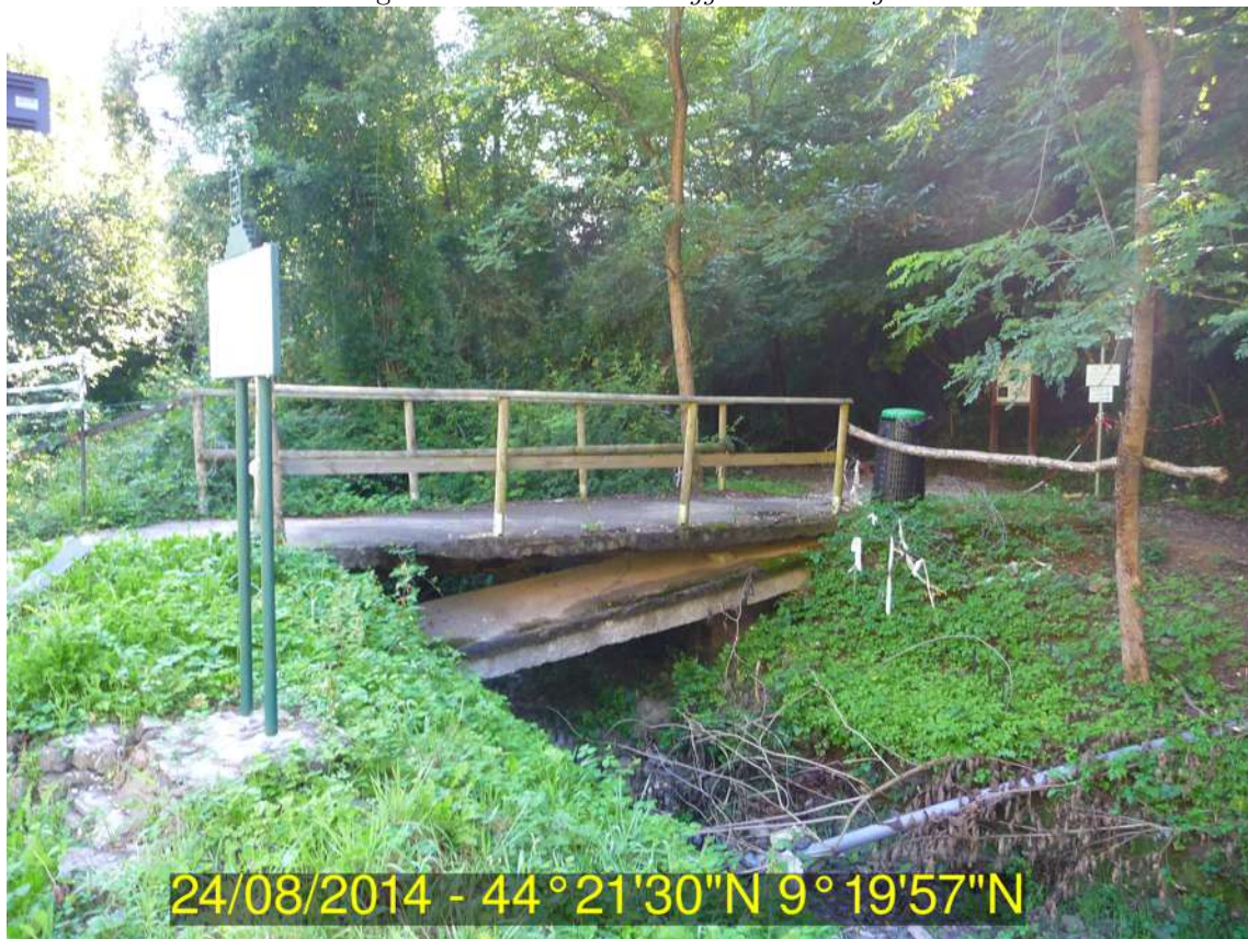
Figura 6: Ponticello danneggiato a Scaruglia
