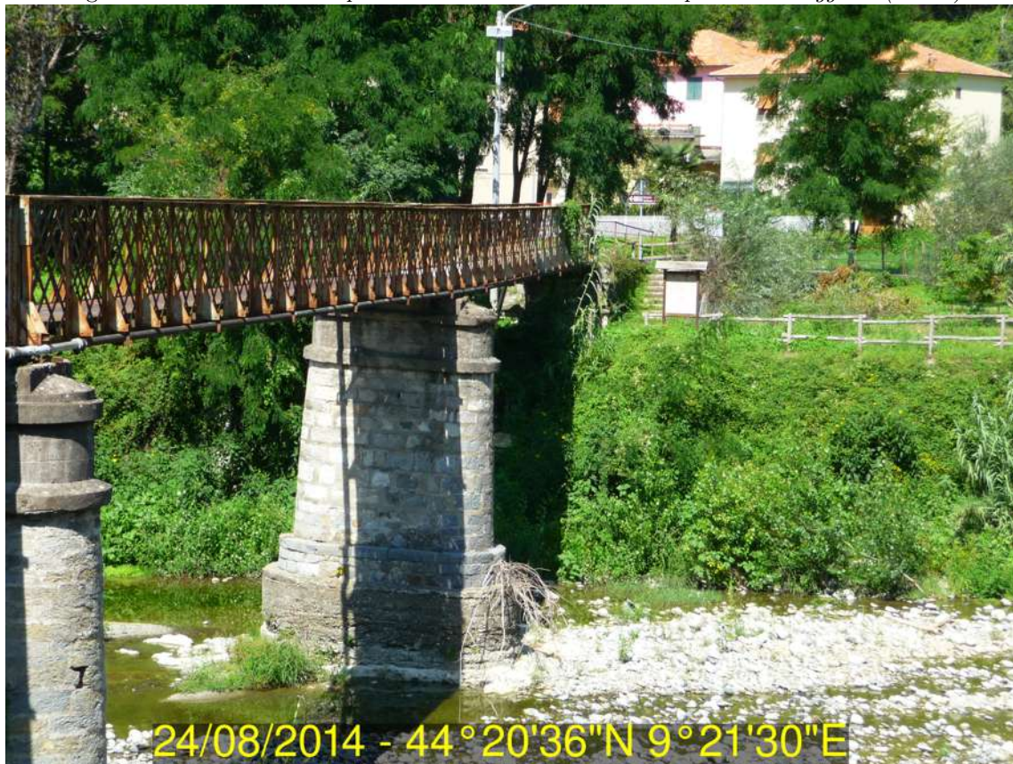
Figura 2: Particolare della passerella di Rivarola. Si noti il pilone danneggiato (storto)
